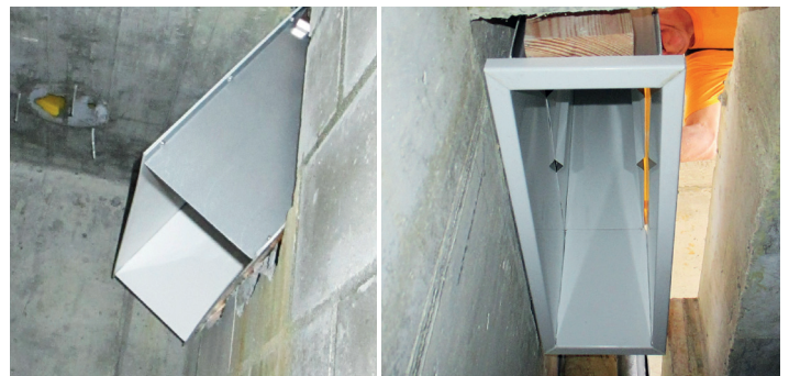
je nach Situation kann die Form des Endstücks variieren
